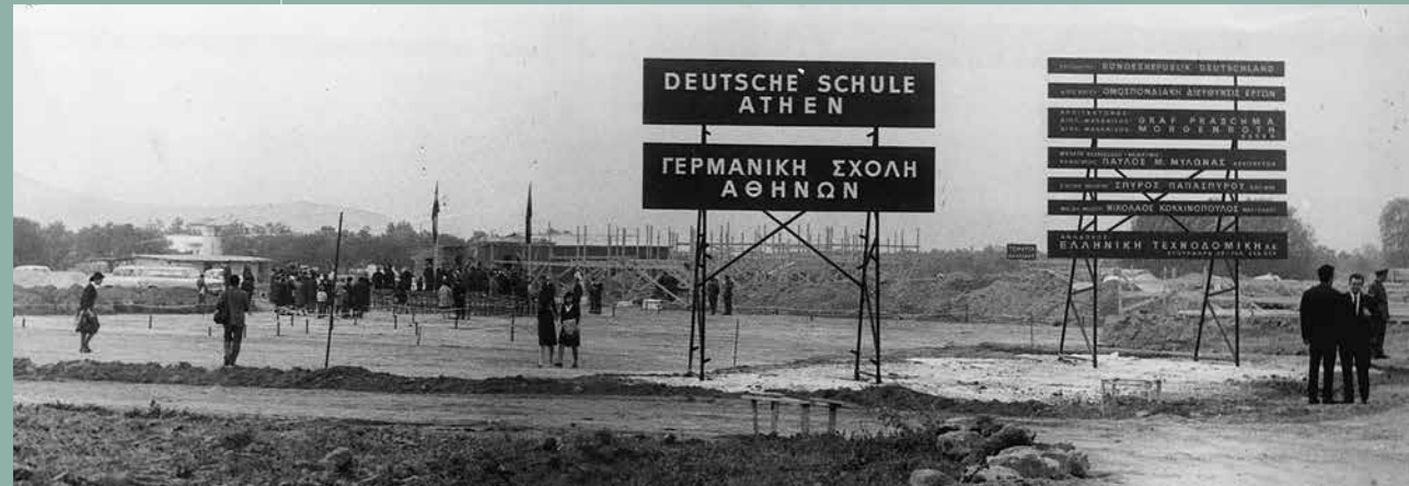
Grundsteinlegung für die neue Schulanlage in Maroussi, 1966.
